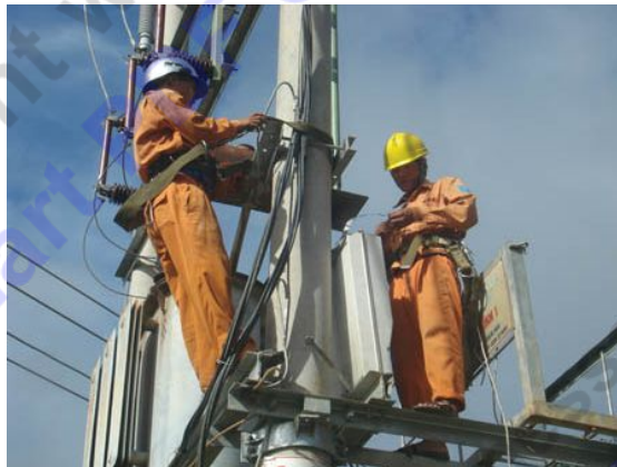
Công nhân Điện lực Hà Tĩnh bảo dưỡng hệ thống điện nông thôn.
